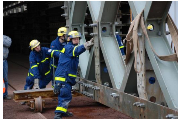
Auf Schienen transportieren die Einsatzkräfte während einer Brückenbauübung vormontierte Brückenteile zum Einsatzort.
