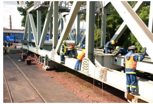
Eine Eisenbahnbehelfsbrücke vom Typ "Schaper-Krupp-Bundesbahn (SKB) wird während einer Übung aufgebaut. Foto: THW
