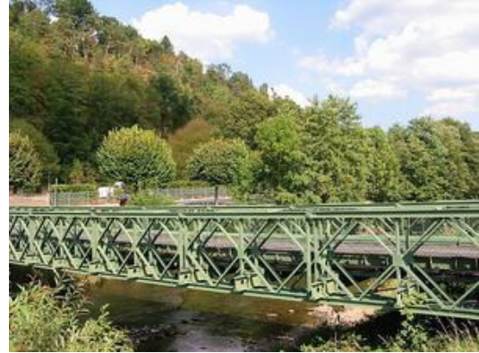
Zweifach ausgebaute Bailey Brücke über einen Fluss. Foto: Cham(Wikipedia)
