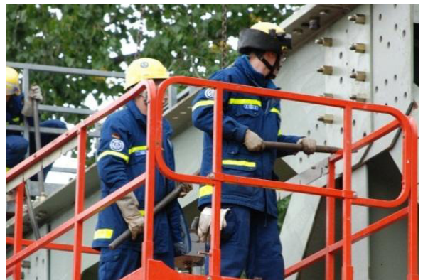
Auf einer Hebebühne arbeiten die Einsatzkräfte beim Bau einer mehreren Meter hohen Eisenbahnbrücke. Foto: THW
