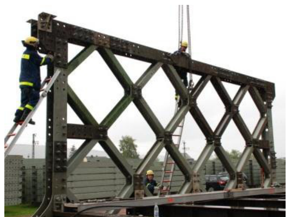
Einsatzkräfte bauen ein Brückenelement des Brückentyps "Straße-Eisenbahn-Gerät" auf.
